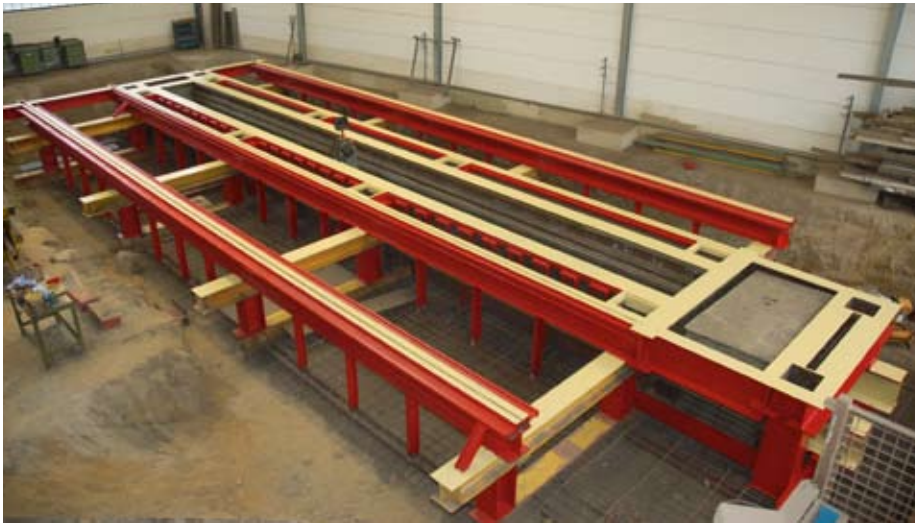
Raschl installiert die wahrscheinlich weltweit stärkste Rahmenrichtbank für Druck- und Zugkräfte von über 1.000 t.
